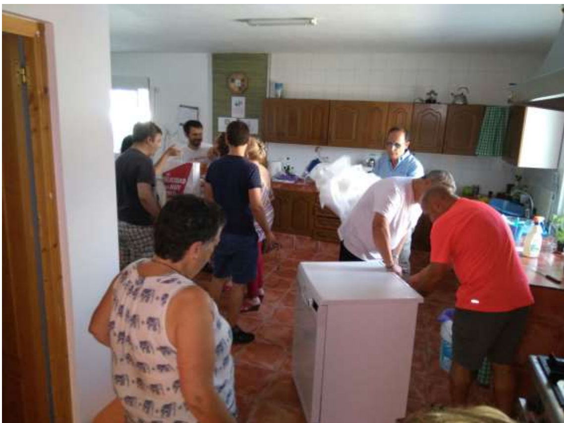
Instalando el lavavajillas en la cocina
